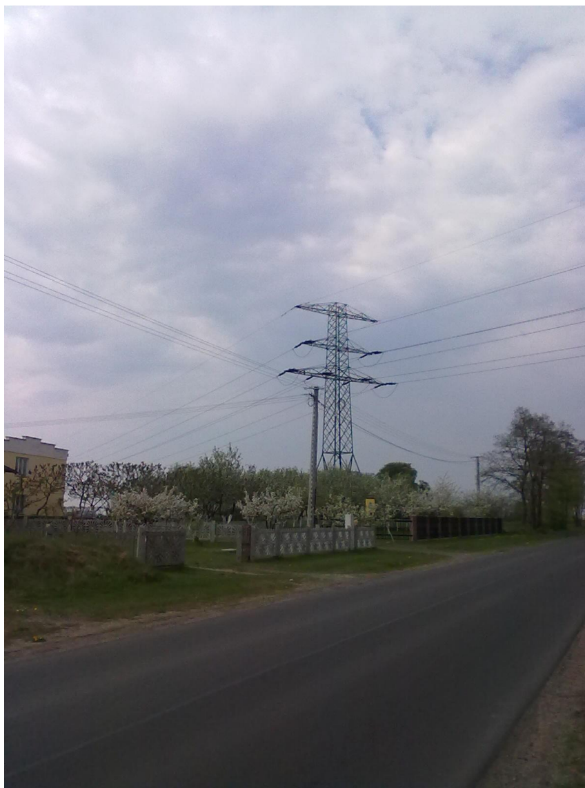
Ryc. 7 Widoczny zmodernizowany fragment linii Nn z siecią przesyłową dwutorowej linii WN – 110kV – droga wyjazdowa z Izbicy do Topólki
