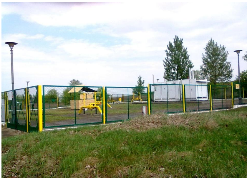
Ryc. 4 Widok stacji redukcyjnej gazu od strony osiedla zabudowy wielorodzinnej przy drodze Izbica Kujawska - Topólka
